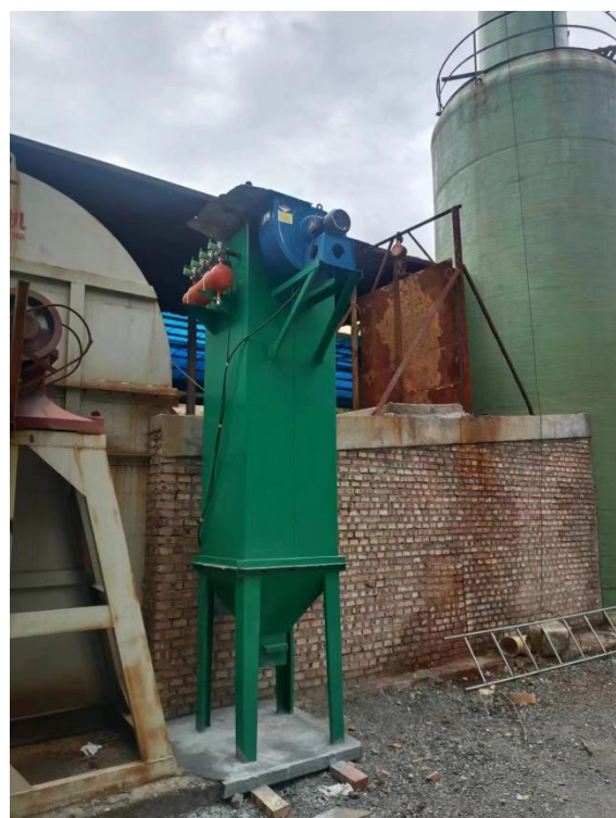
隧道窑布袋除尘器、排气筒
